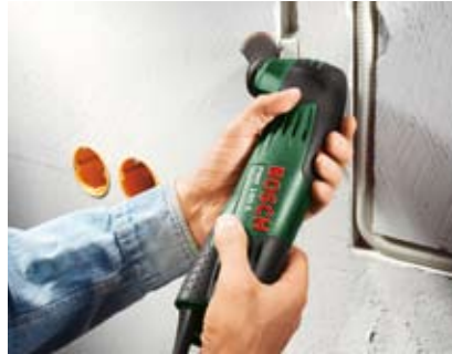
Kabelkanal schneiden.
