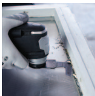
Ablakozó gitt (tömítőmassza) vágása
