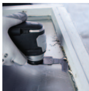
Skæring af vindueskit (tætningsmasse)
