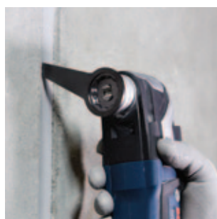
Skæring af ekspansionsfuger
