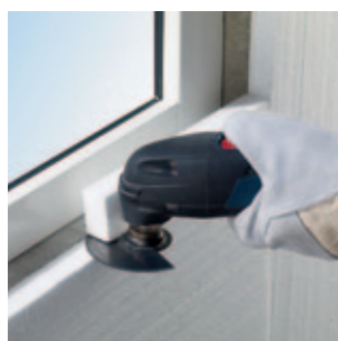
Planafkortning af udragende isoleringsmateriale, f.eks. styropor
