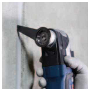
Skjæring av ekspansjonsfuger
