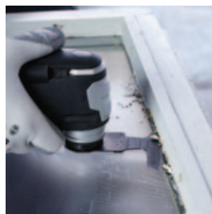
Skjæring av vinduskitt (tetningsmasse)
