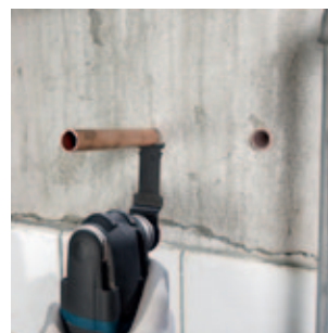
Flächenbündiges Trennen eines überstehenden Kupferrohrs
