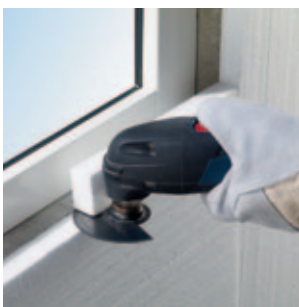
Flächenbündiges Ablängen von überstehendem Isolationsmaterial, z.B. Styropor
