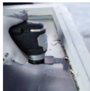
Schneiden von Fensterkitt (Dichtmasse)
