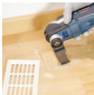
Tauchschnitt in Laminat, z. B. für Einbau in Lüftungsgitter
