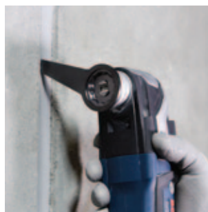
Schneiden von Dehnfugen
